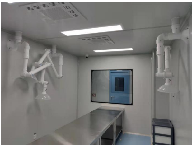
实验室集气罩装置
